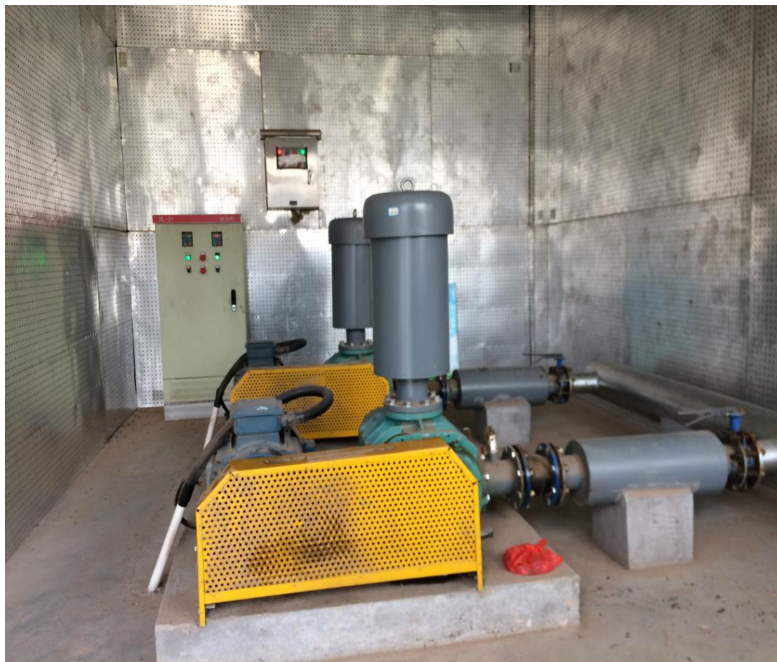
附图 5：鼓风机房吸声墙
