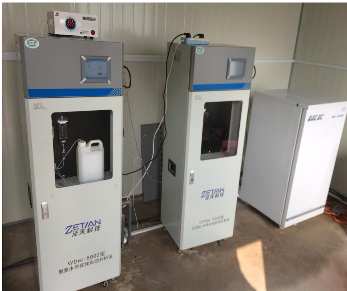
附图 3：进、出水在线监测装置
