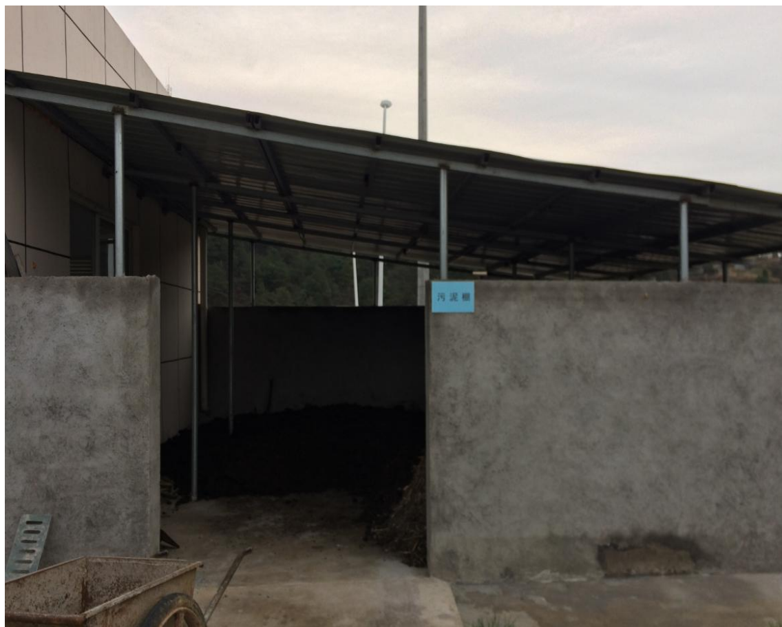
附图 1：污泥暂存场所
