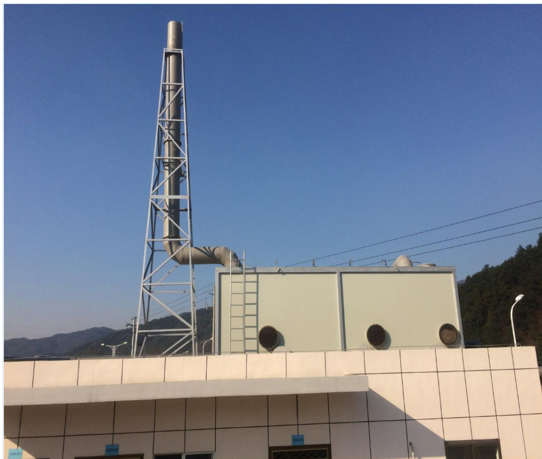
附图 2：废气除臭装置及排口
